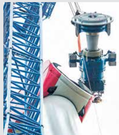
Getriebestrang ... wird in die Gondel eingebracht
