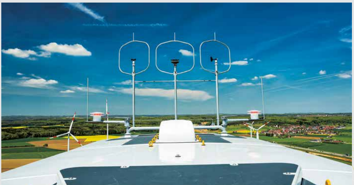
Generatordach mit Sensoren für Windgeschwindigkeit, Windrichtung und Luftdruck
