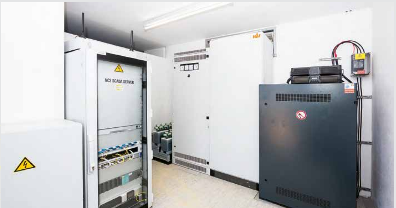
Netzeinspeisung mit USV und Datenübertragung
