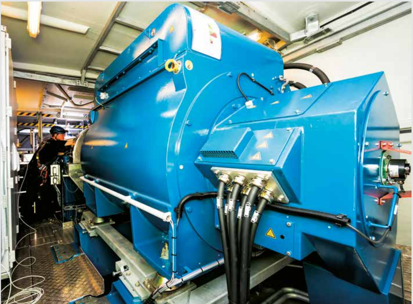
Maschinenhaus und Generator
